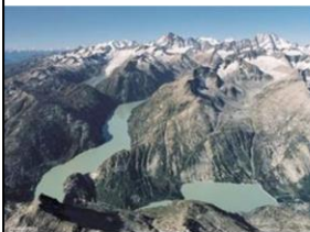
Kraftwerksanlagen auf der Grimset
